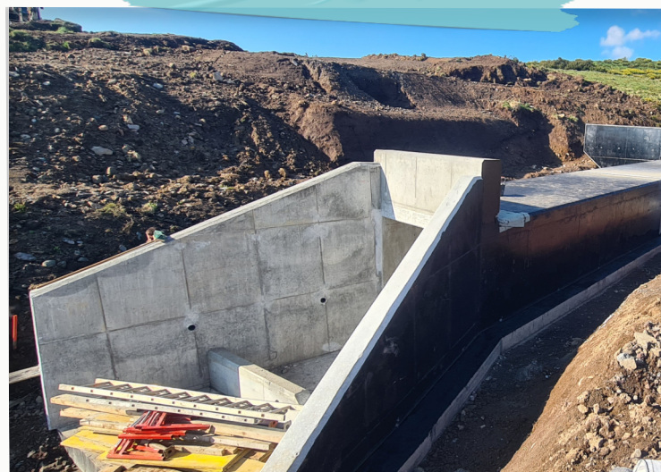
Réfection du pont
