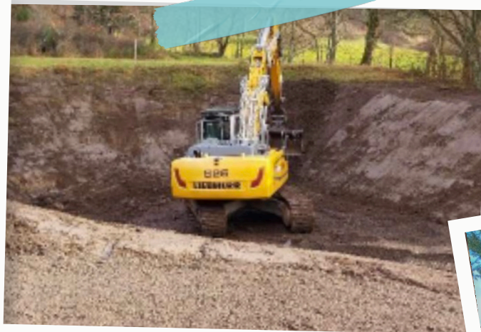
Démolition de l'ancien château d'eau
