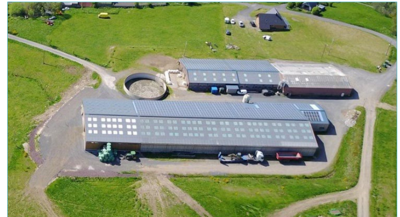
Bâtiments agricoles récents à Chambon-sur-Lac (Village de Bressouille) - ©Acheteralasource.com
